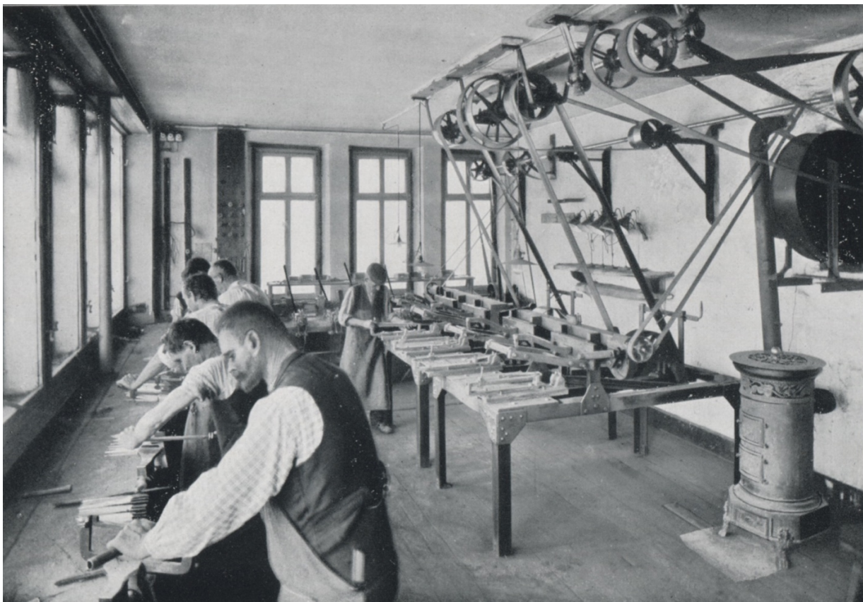
Meulage de la tranche. Le crochet pivotant autour d'un axe permet d'appuyer la lime contre la meule. Les meules de grès qui font plus de 2 mètres de diamètres s'usent rapidement, après 2 ou 3 mois il faut les remplacer.
